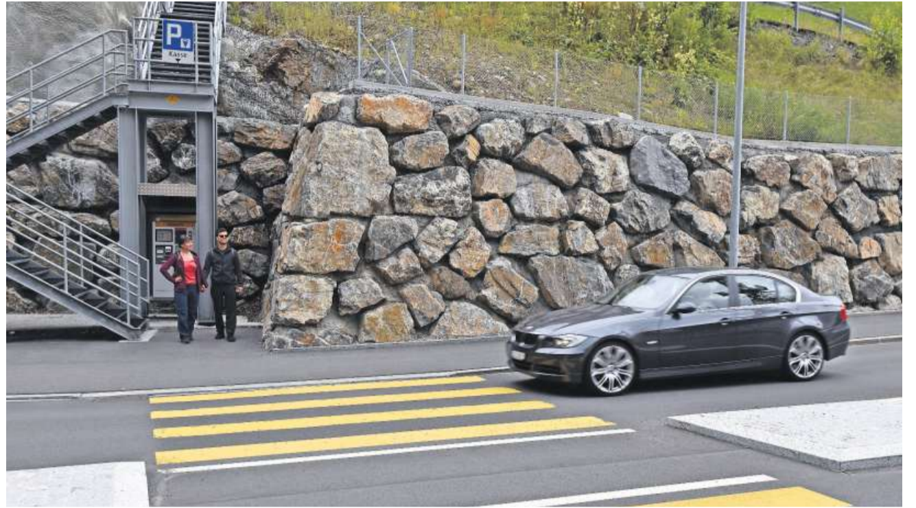
Die Gäste der Stoosbahn kommen vom oberen Parkplatz. Sie bleiben lange hinter der Mauer versteckt, bis sie erst kurz vor dem Betreten der Strasse für den Automobilisten sichtbar werden. Bild: Andreas Seeholzer
